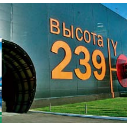
Цех «Высота-239» ОАО «ЧТПЗ»
