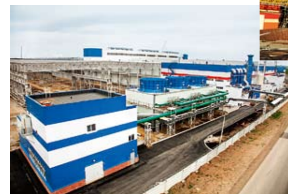
Первая очередь прокатного комплекса на ОАО «КУМЗ»
