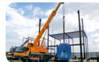
Установка котла BUDERUS мощностью 20 Мвт/час, массой 40 тонн
